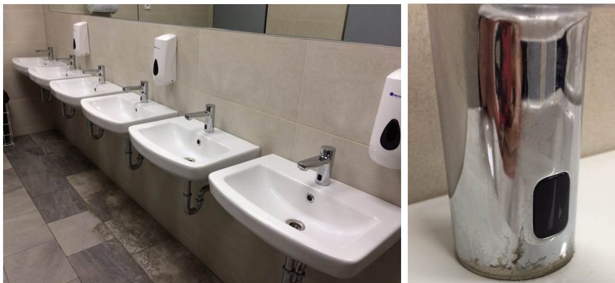
Obrázek 3: Poškozené baterie
